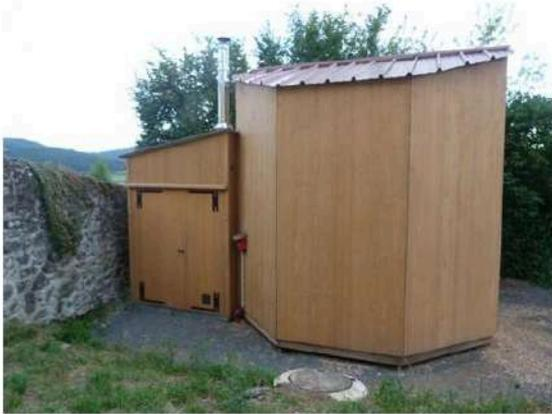
Vous avez sûrement remarqué ce nouveau bâtiment installé dans la cour au pied de la mairie. Il s'agit de la nouvelle chaufferie bois : une partie chaudière et une partie silo. Et oui, depuis ce mois de janvier, fini les odeurs de fioul dans la mairie, la vieille chaudière a été remplacée par un micro réseau de chaleur qui permet de chauffer et de fournir l'eau chaude pour deux bâtiments : la mairie et une maison particulière.
